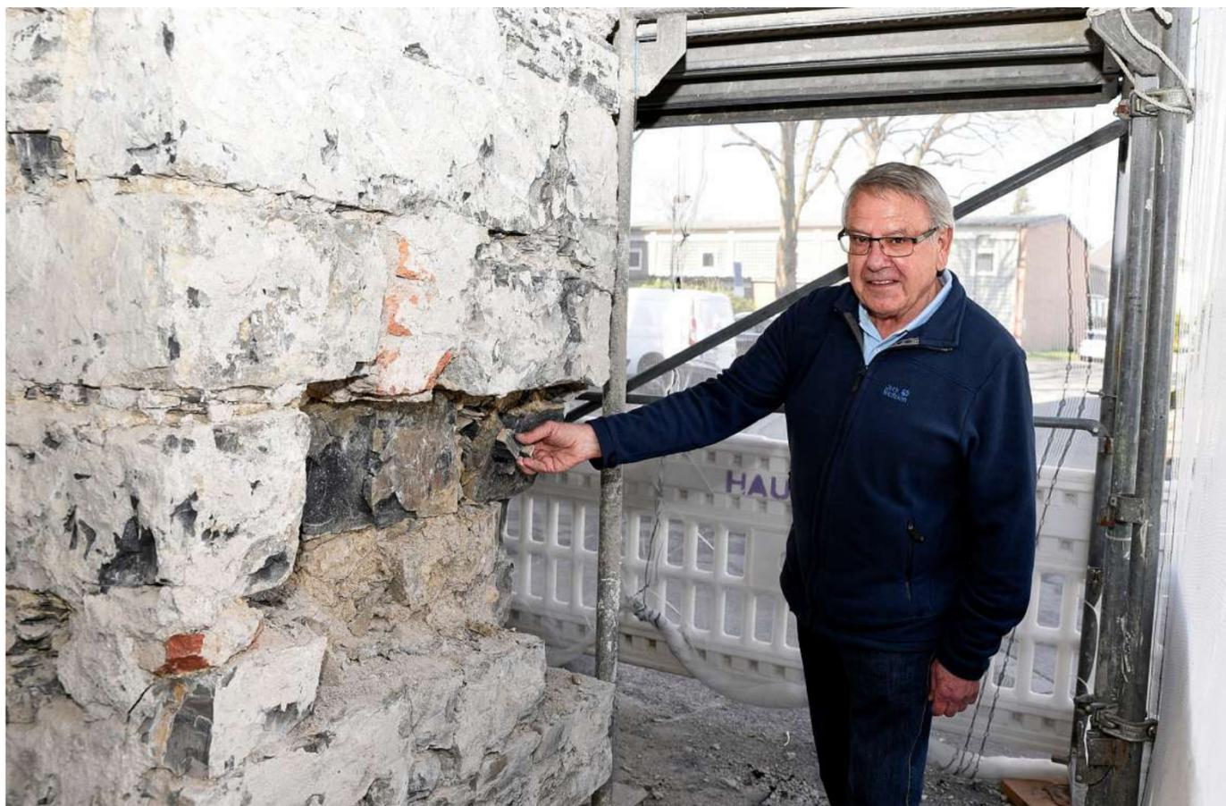
**An einer Wand der Bruchhausener Rodentelgenkapelle zeigt Dieter Ischen eine Stelle, an der ganze Bruchsteine im Verlauf der Sanierungsarbeiten herausgebrochen sind. Zuvor war der rissige Außenputz abgeschlagen worden.** FOTO: FRANK ALBRECHT
