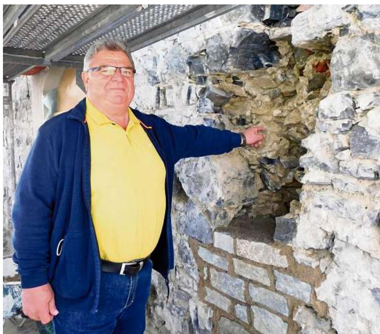
Norbert Hollmann zeigt auf ein Loch in der Kapellengiebelwand, in der sich Bruchsteine lösten. Mit neuen Bruchsteinen wird es zugemauert.
