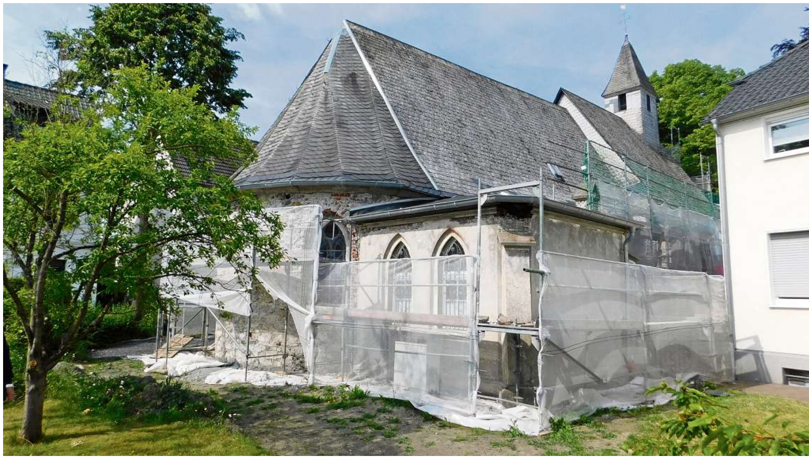
Die Außensanierung machte ein Einrücken der Bruchhausener Rodentelgenkapelle erforderlich. Nach dem Abschlagen des Putzes wurde offenkundig, dass insbesondere viele Bruchsteine in Pfeilern und Wänden ersetzt werden müssen. FOTO: MARTIN SCHWARZ
