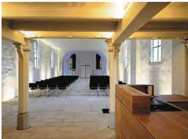
Ein Restaurierungskonzept für die Kapelle wurde ab 2014 erarbeitet und von 2016 bis 2018 umgesetzt.
